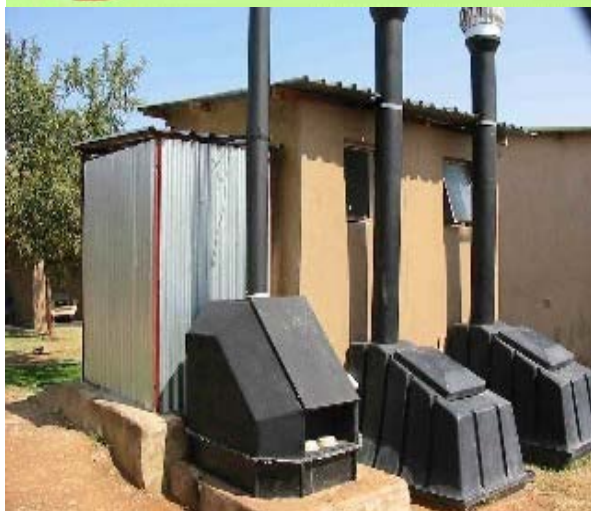
Фигура 8: Enviro-Loo система (Enviro Options Australia Ltd.)
